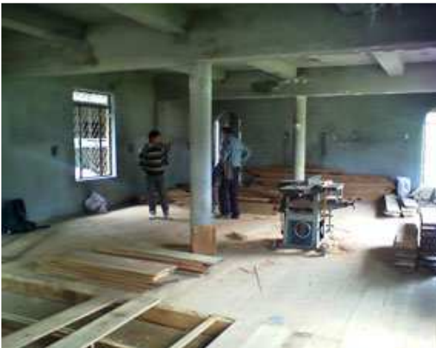
Albert Vogt und einige Handwerker bereiten das Shal Hartholz für den Fußboden in der Meditationshalle vor.
